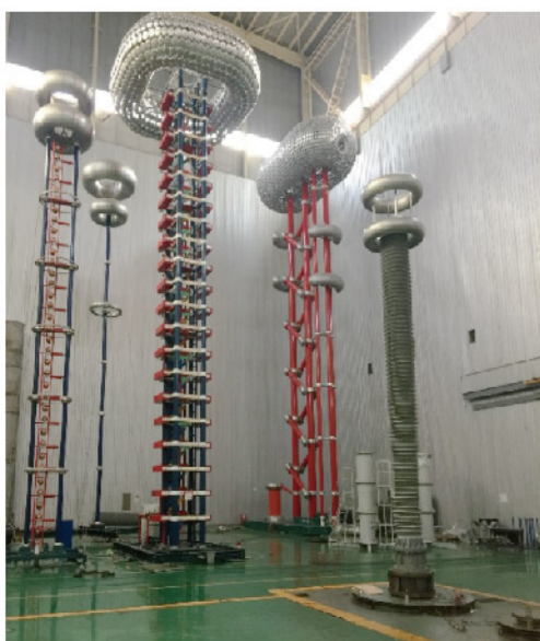
Плановые испытания трансформаторного ввода
