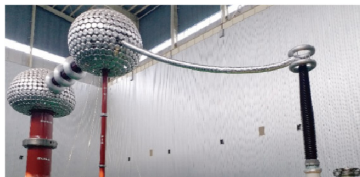
Плановые испытания наружного ввода КРУЭ, 550 кВ
