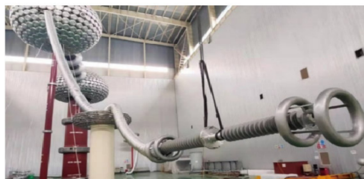
Плановые испытания линейного (проходного) ввода, 550 кВ
